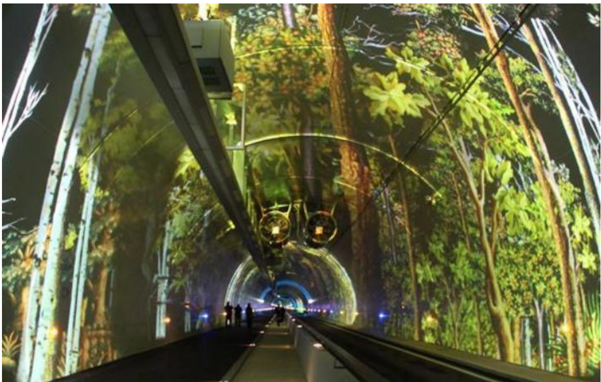
Galerie de sécurité du tunnel routier de la Croix-Rousse à Lyon, France (Skertzo, Disonic)
