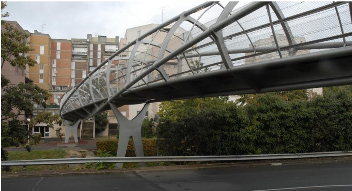
Passerelle au-dessus du périphérique à Evry, France Crédits photographiques : DVVD
